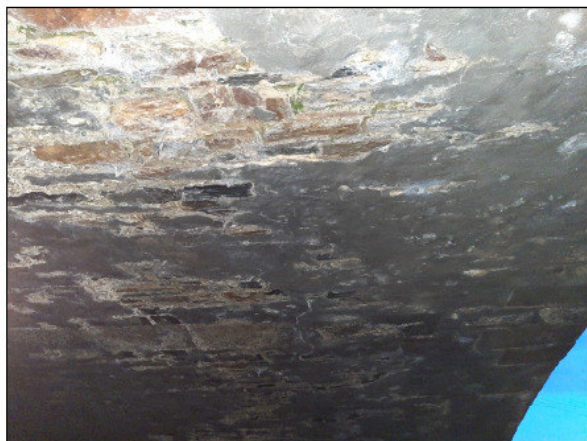
Obr. A 2 – Typický stav podhledu klenby v polích (vlevo) a stav opěry (vpravo)
